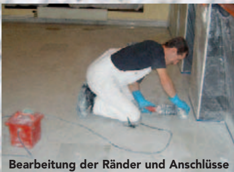
Grobschleifen von Natursteinböden
